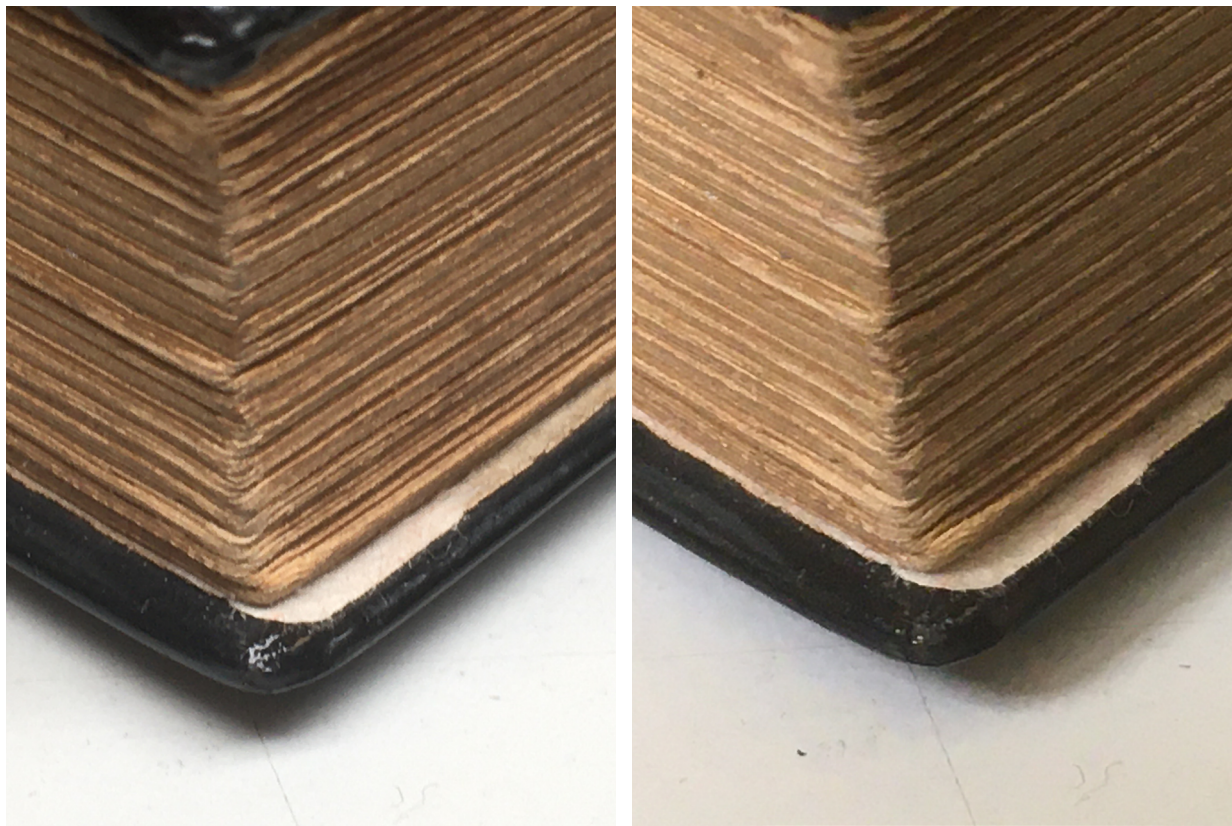
Obr. 19 Rohy před (vlevo) a po (vpravo) restaurování
