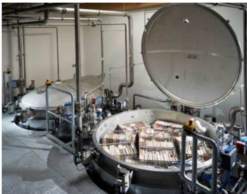
Technologické zařízení ZFB:2- Verfahren ve firmě ZFB. Fotografie ZfB.
